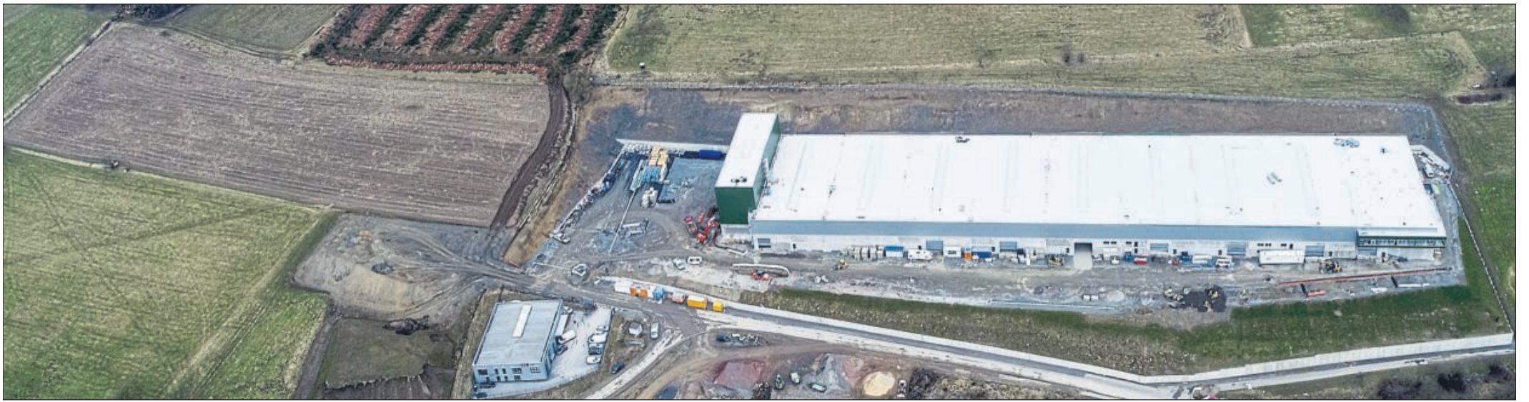
Die mittlerweile komplett fertiggestellte Junior-Halle aus der Vogelperspektive. Die rund 100 000 Quadratmeter große Ackerfläche links hat sich das Unternehmen bereits für die weitere Expansion gesichert. • Foto: Wiechowski
